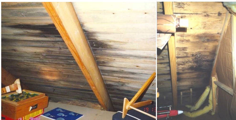
Figur 5 Mögelpåväxt på insidan yttertak.
