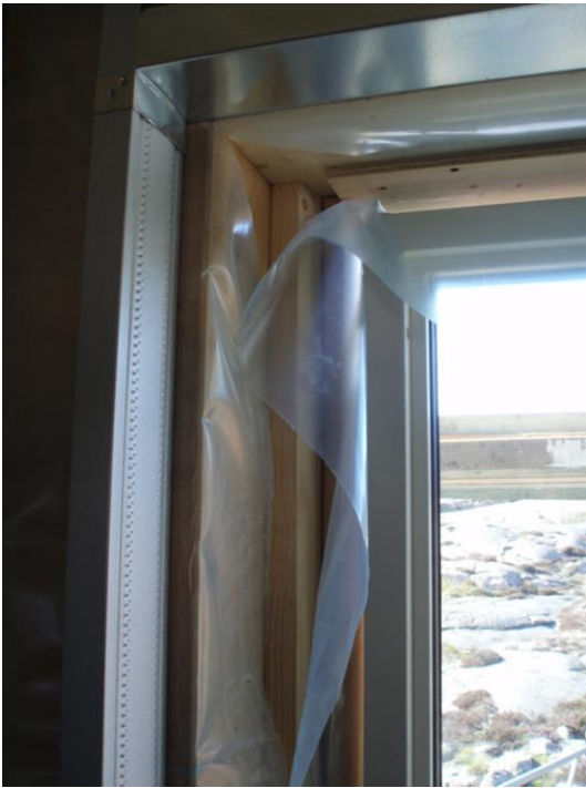
Figur 37 Fönstret är monterat i stommen och plastfolien ansluts mot väggens plastfolie.
