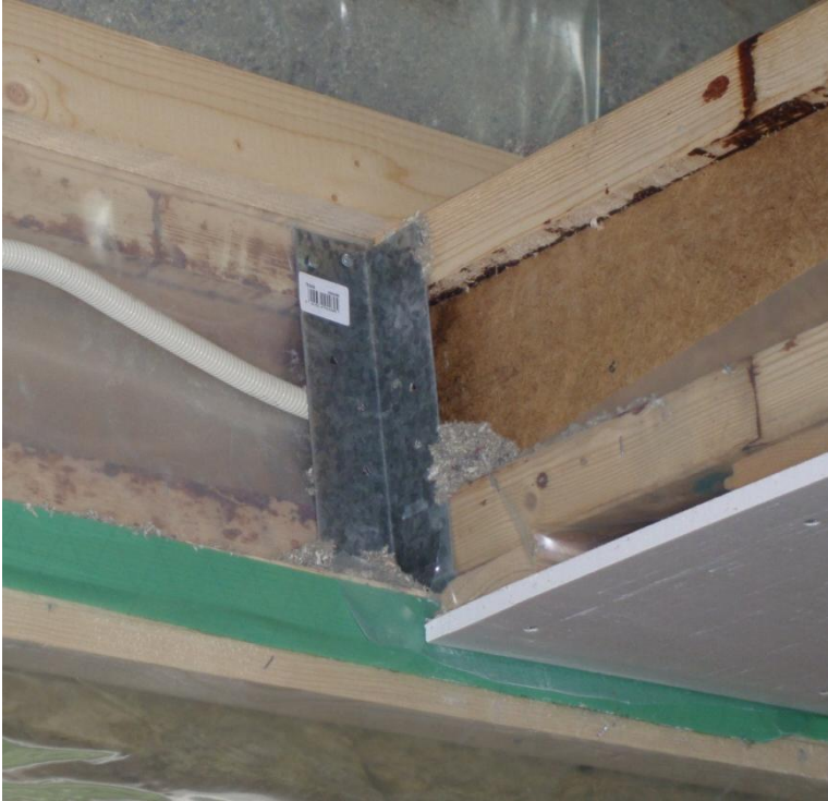
Figur 33. Infästning av mellanbjälklag mot yttervägg med balksko. Väggs plastfolie är heldragen förbi bjälklaget.
