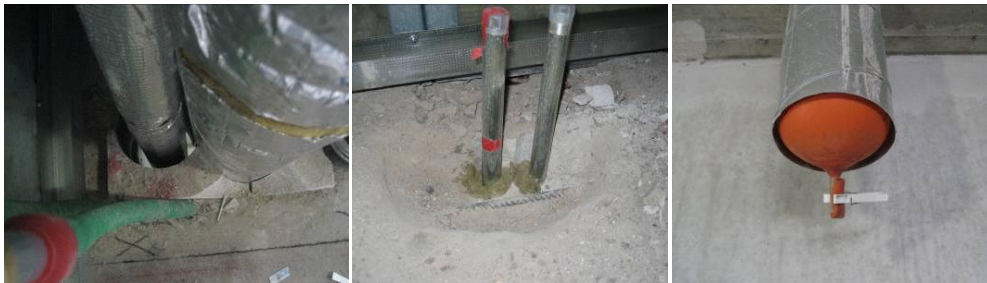
Figur 54 Hål kring genomföring i bjälklag, tätning med mineralull kring rör samt ventilationsrör tätat med ballong.
