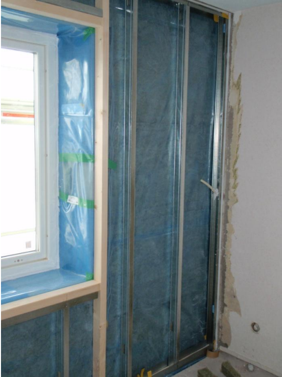
Figur 19 Exempel från renovering: indragen plastfolie och omsorgsfull anslutning av tätskikt mot fönster med tejning och fogning kring fönstret.
