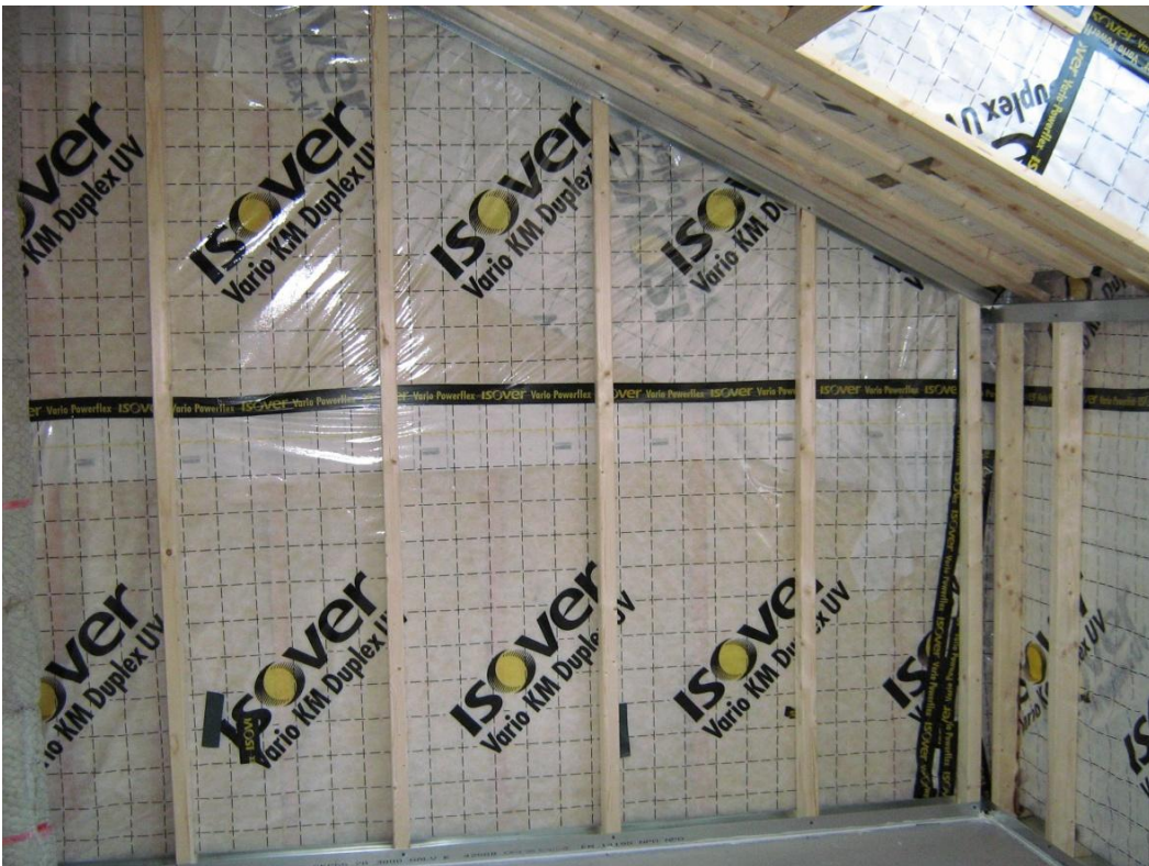
Figur 20 Exempel på indragen plastfolie (innan inre isolering är på plats).
