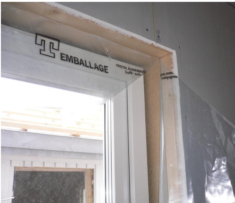
Figur 38 Plastfolien kläms mellan regelstommarna.
