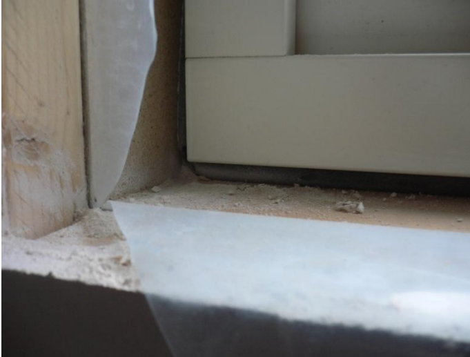
Figur 39 Fönstret är noga drevat (med plastad mineralull) och tätat (med svällist).
