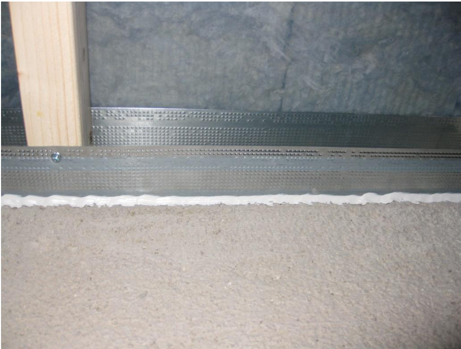
Figur 26 Exempel på lufttät anslutning mot golvkonstruktion. Plastfolien går bakom installationsskiktet, under plåtregel (som har pålimmad flexibel syllisolering) och därefter fogas plastfolien mot betongen.
