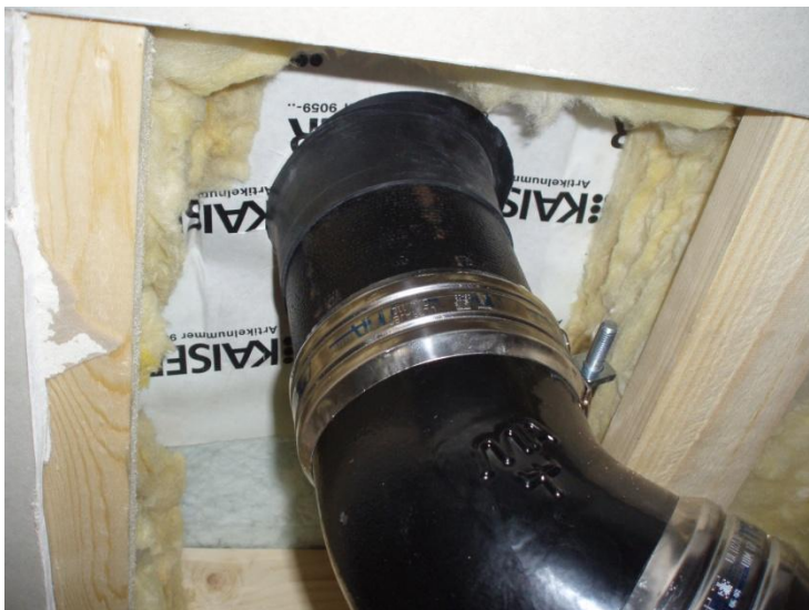
Figur 44 Stos kring avloppsluftare.
