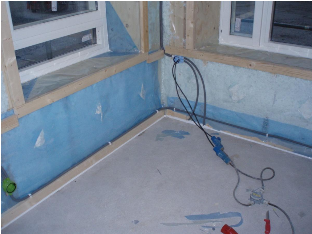
Figur 49. Hål i plastfolien för att spruta lösull.
