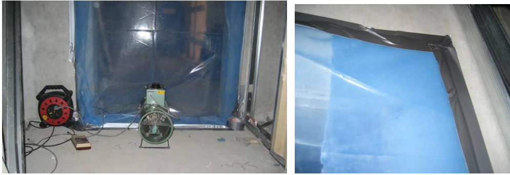
Figur 55 Fläkt och manometer monterade i dörr mot trapphus, tätning kring dörr.
