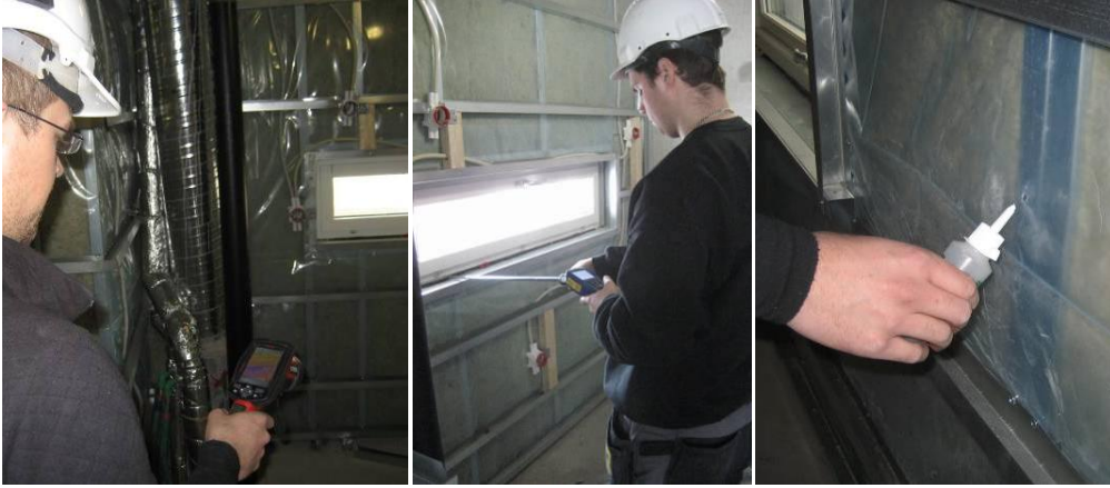
Figur 56 Läckagesökning med värmekamera, lufthastighetsmätare och rökgas.
