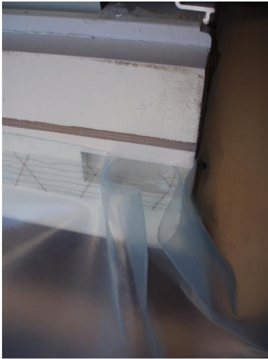
Figur 35 Vikning av plastfolie kring fönsterhörn.
